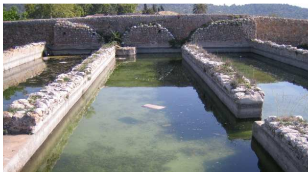
Foto 1. Bassa a Son Fortesa. Es poden veure els tres caps de volta de canó, amb el dos laterals rectificats exteriorment a escaire.
